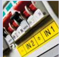
Elektrické rozvádzače a panely
